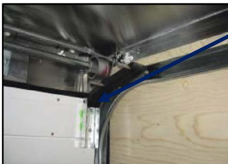
Pour la plupart des portes, le haut du support argent sera +/- 1/4" du haut de la porte. Les supports de rouleaux supérieurs doivent être fixés et parallèles aux rails, à partir du bord du panneau par 1/4".
