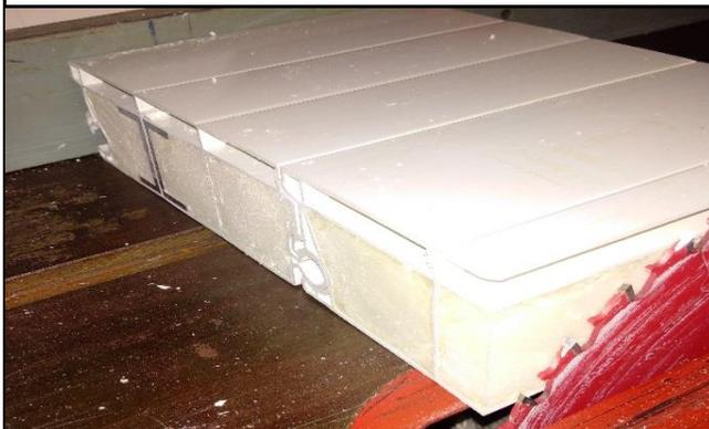
**Étape 3.** Faites glisser le joint du capuchon supérieur sur le bord coupé du panneau, le joint flexible noir faisant face à la surface extérieure.
