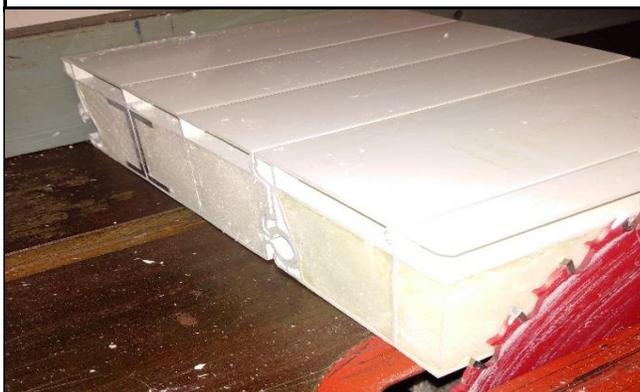
**Paso 3.** Deslice la junta de la tapa superior sobre el borde cortado del panel con la junta flexible negra hacia la superficie exterior.
