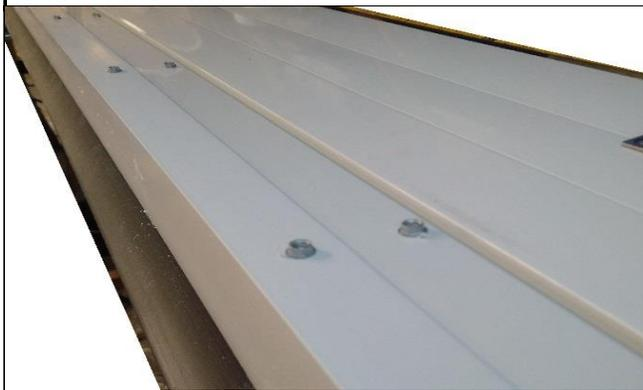
**Paso 5.** Inserte dos barras planas en las 2 primeras cámaras de PVC sin cortar debajo de la junta superior. Repita la operación en los modelos alternativos. Se debe utilizar un martillo para insertar los canales en los modelos aislados.
