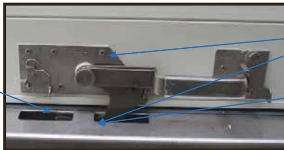
Borde del corte en la línea central de la abertura (alineado con el remache que marca el punto central del cierre). Varilla redonda o media luna bajo el corte a ras del borde. Profundidad total del umbral del piso y de la varilla redonda = 9/16".
